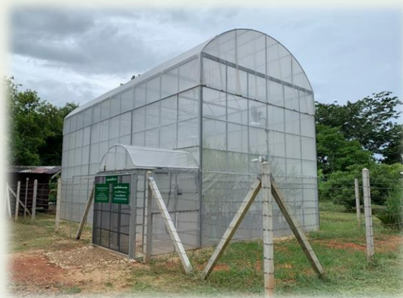
โรงเรือน (Greenhouse) มุ่งตาข่าย ขนาดพื้นที่ 48 ตารางเมตร ความสูง 5.5 เมตร
